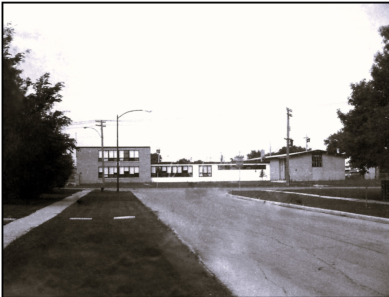
Deuxième école Sainte-Marie (1957-1974) située au 29 rue Des Meurons entre les avenues Vivian et Morier
